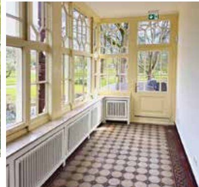
In der wintergartenähnlichen Teeküche der Villa wurden die alten Fensterfüllungen durch neue 4-mm-Flotglasscheiben ersetzt. Darüber hinaus wurden die alten Beschichtungen entfernt, schadhafte Holzteile ersetzt, Beschläge gereinigt und erneuert sowie die Fenster von außen und innen neu lasiert.
