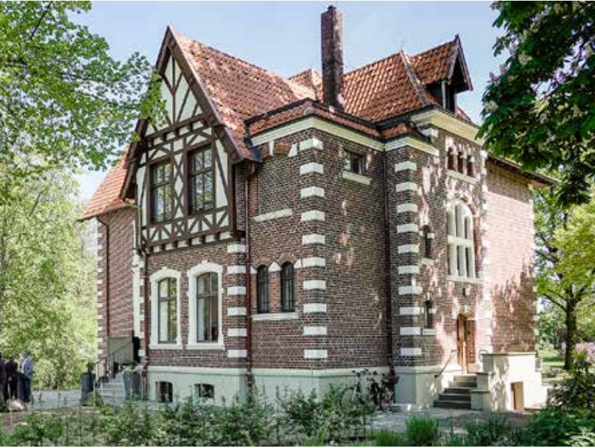
Von Frühjahr 2024 bis April 2026 wurde die 1896 erbaute Villa im Schlosspark Strünkede in Herne als städtische Galerie grundlegend saniert.
