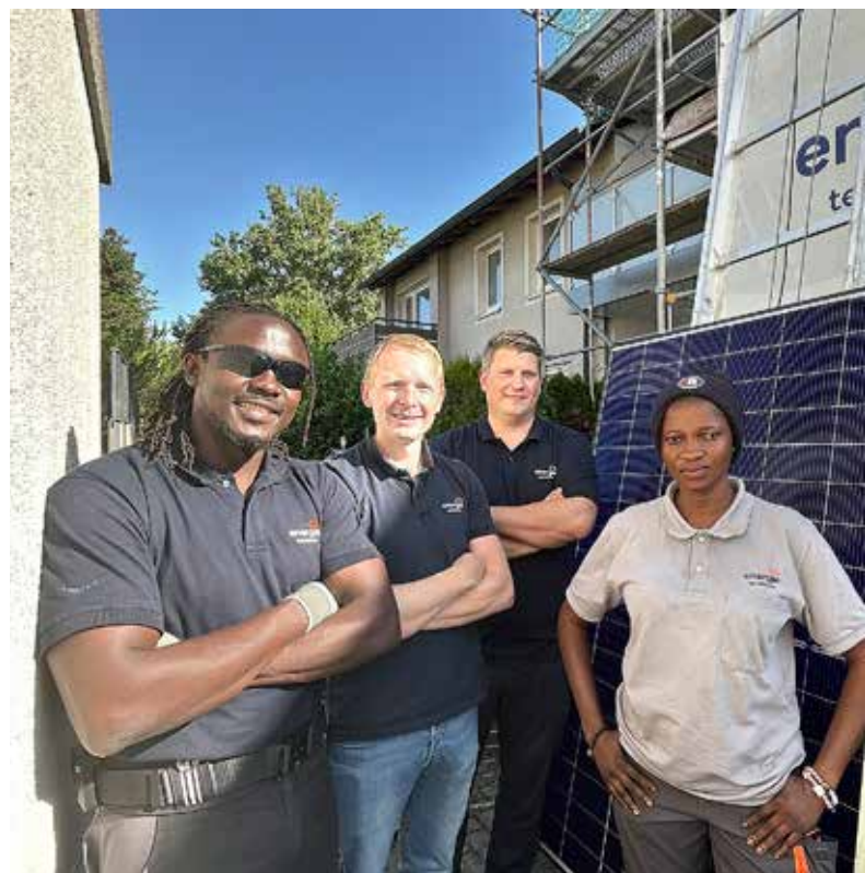
Abu-Rashidu Mama-Toure, Benjamin Wagner, Johannes Golücke und Gladys Tameah (v.l.) auf einer Baustelle in Bochum, wo eine Solaranlage auf dem Dach installiert wird.
